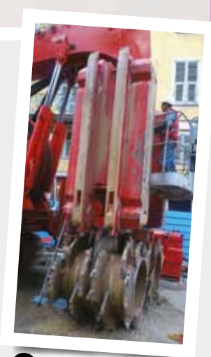
A L'hydrofraise, la machine à creuser.
